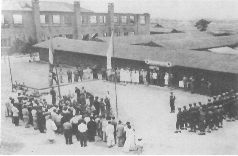
6.25전쟁 발발 후 우신초등학교에 주둔한 이탈리아 의무부대 (1952) 간호장병과 자원봉사자로 이루어졌던 이 부대는 1951년에 이 학교에 임시 진 료소를 세우고 22만여 명의 군인과 민간인 부상자들을 진료했다.
