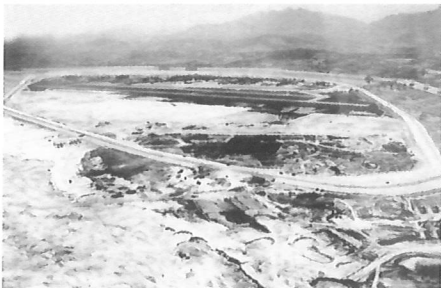
여의도 개발 공사 중 모습(1968)
